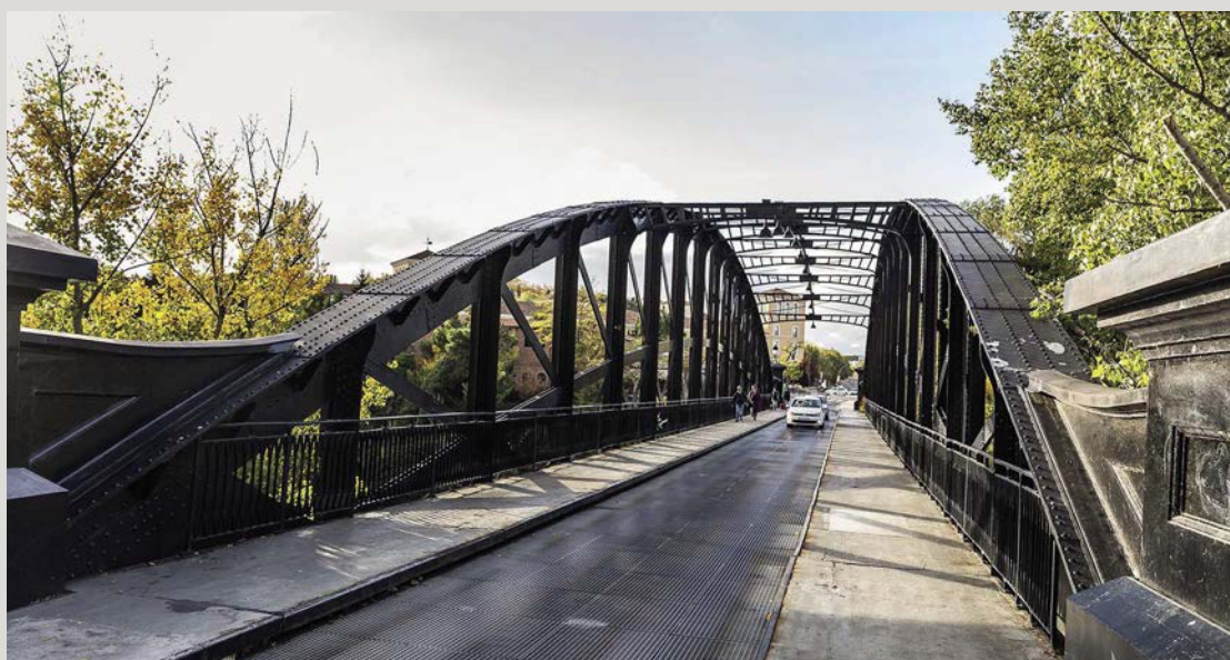
PUENTE COLGANTE , Valladolid - España
